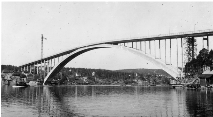
4 S. Höggbom, chief engineer, Skånska Cement Co., Sandöbron (Sandö Bridge) spanning 866 feet over the Ångerman River, Sweden, 1937–43. Skånska Co. Archives of the Centre for Business History [Centrum för Näringslivshistoria], Bromma, Sweden (photograph provided by the Skånska Co. Archives of the Centre for Business History [Centrum för Näringslivshistoria])
